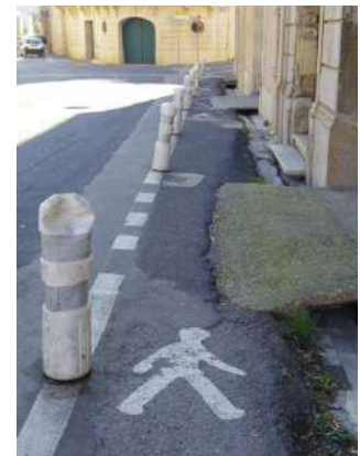
Aménagement piéton place de l’église
