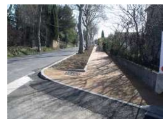
Nouvel aménagement piéton avenue de la Gare
