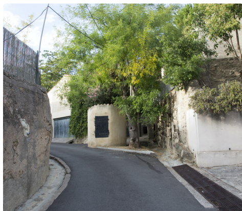
Travaux rue du Puits de Jacob
