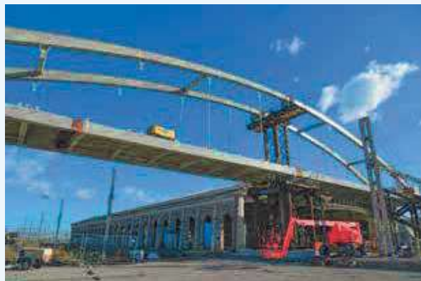
Ci dessus la nouvelle passerelle du PEM de Sète
