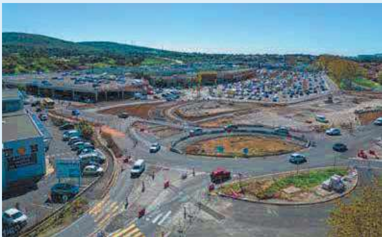
Ci-contre, les travaux de la gare routière multimodale de Balaruc-le-Vieux mise en service en novembre 2023.
