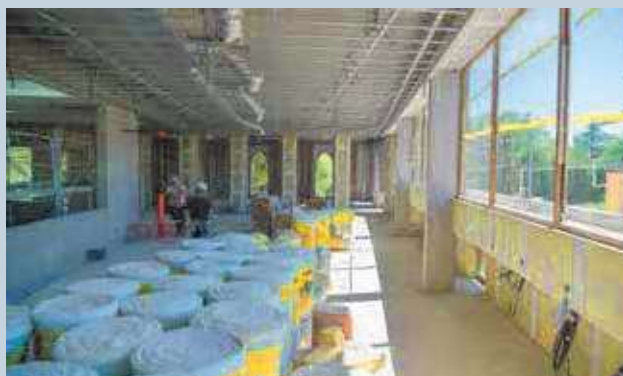
Ci-dessous la construction de la médiathèque intercommunale de Balaruc
