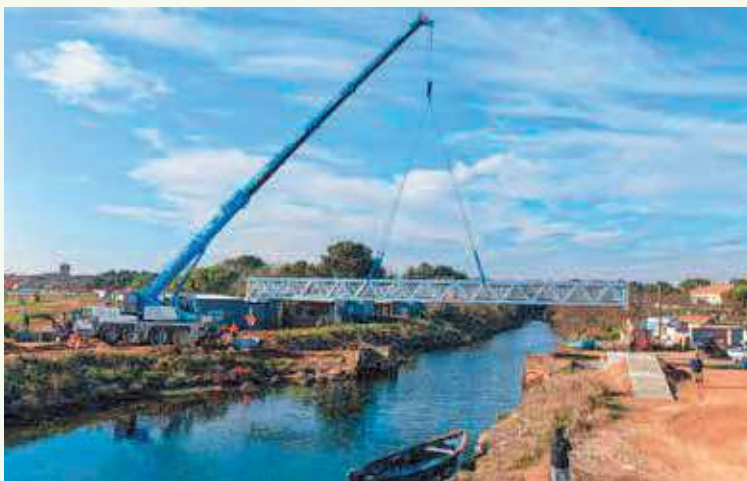
A Mèze, la pose de la passerelle de 26 mètres de long, au dessus de l'embouchure du Pallas, pour relier les deux rives.
