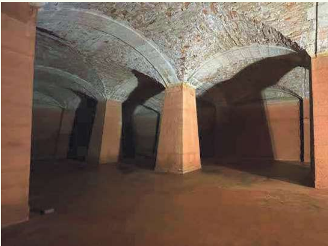
Ci-contre, le réservoir d'eau de Sète.
