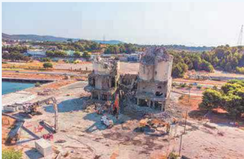
Travaux de destruction du site Lafarge
