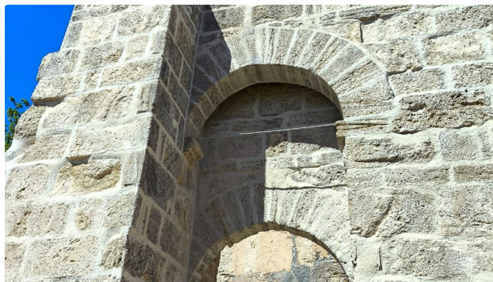
Rénovation de la porte romane
