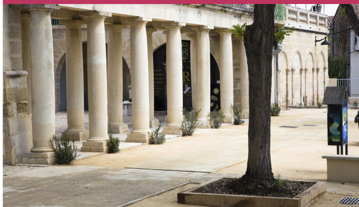
Chantier d'insertion place des Colonnades
